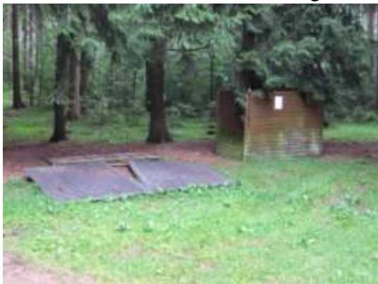
Abb.: zerstörte Schutzhütte, inzwischen wieder aufgebaut.
