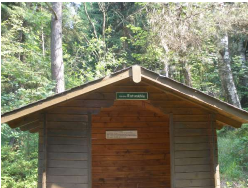
Abb.: Schutzhütte Ratsmühle
