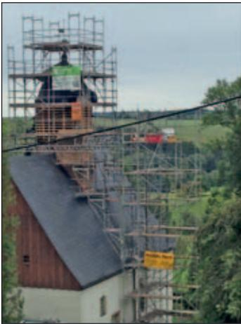
Seit August ist der Turm der Friedhofskapelle eingerüstet. Am Dachreiter müssen statisch wichtige Zimmererarbeiten ausgeführt und die komplette Außenhaut erneuert werden. Er wurde seither neu verschalt, Übergänge aus Kupferblech wurden gefertigt und neue Schindeln aus Eichenholz werden angebracht. Wir sind sehr froh, dass mit dieser Baumaßnahme die Sanierung der Friedhofskapelle, die in den Jahren 2011-2012 begonnen wurde, nun zu einem Abschluss geführt werden
