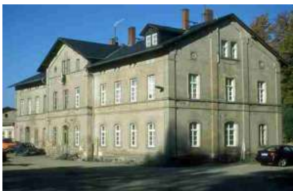
Abb.: Klingenberg Empfangsgebäude 2000
