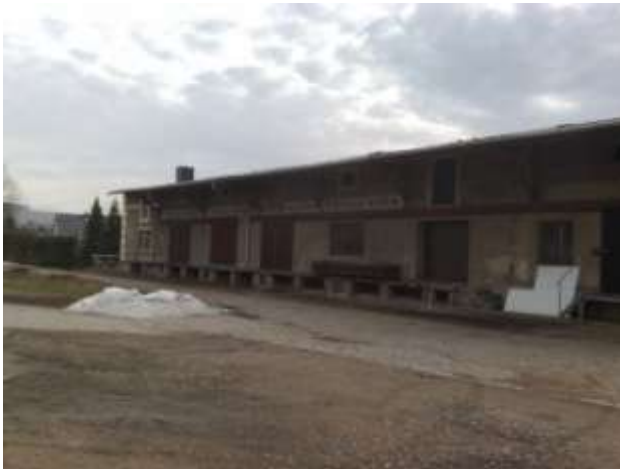
Abb.: Güterrampe in Burkersdorf
