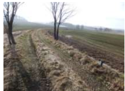
Abb. rechts: Bahndamm Richtung Oberbobritzsch
