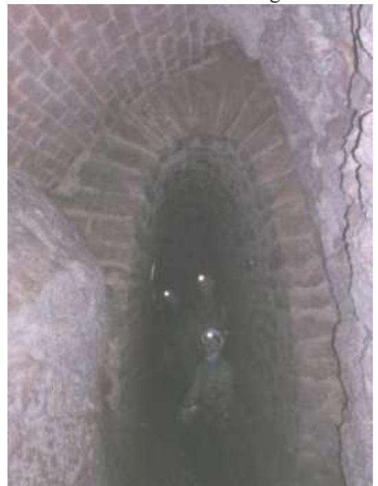
Abb.: Ausmauerung einer Gangstrecke
